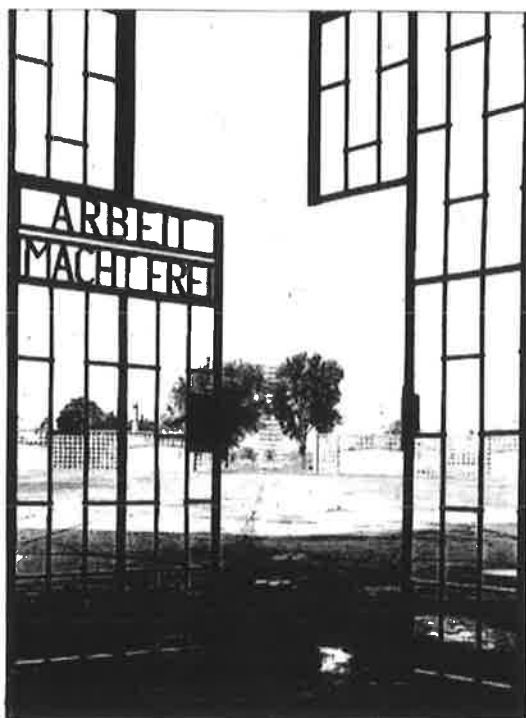
DAS EINGANGSTOR am Turm A.
